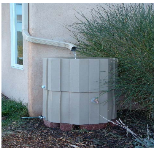
Un sistema di collettamento da pluviale per la raccolta della pioggia (da www.aridsolutionsinc.com )
